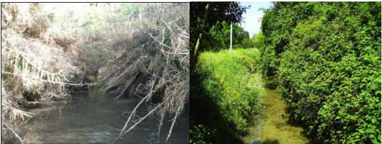
Figure 8 : Tronçons non entretenus – présence de Cannes (à gauche) et de ronces (à droite) créant un obstacle à l'écoulement des eaux
