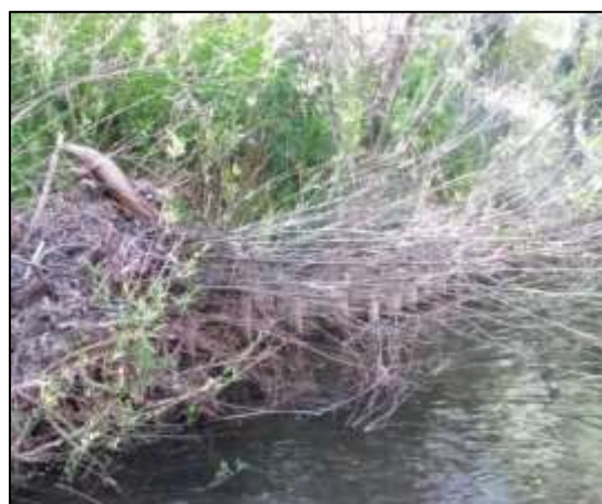
Figure 12 : Fascine de Saules dont le développement est susceptible de constituer un obstacle à l'écoulement
